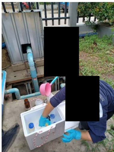
บ่อตรวจสอบคุณภาพน้ำทิ้งก่อนระบายลงท่อระบายน้ำสาธารณะ
